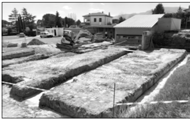
COMENCEN LES OBRES DEL CAMP DE LES LLOSES
